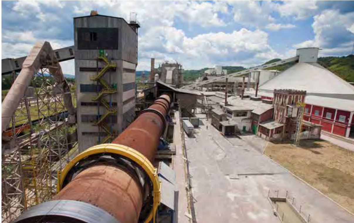
Cuptor de clinker, vedere de la capul rece spre capul cald; în stânga hala morii de cărbune, în dreapta silozul de clinker
