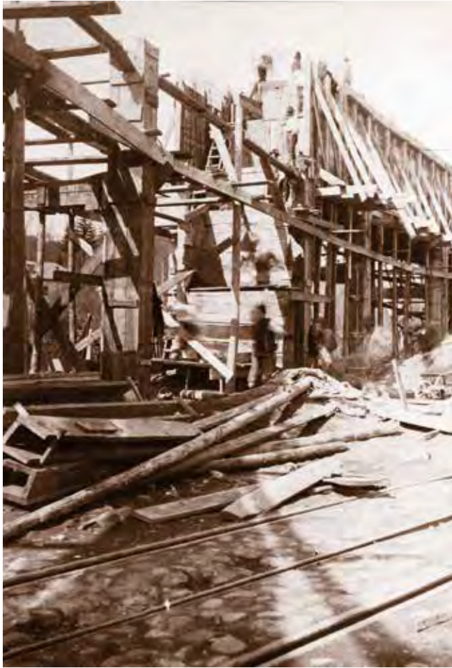
Cofrag la canalul de apă construit până în 1920, prin care apa din râul lalomița este trimisă turbinelor de tip I. M. Voith.
