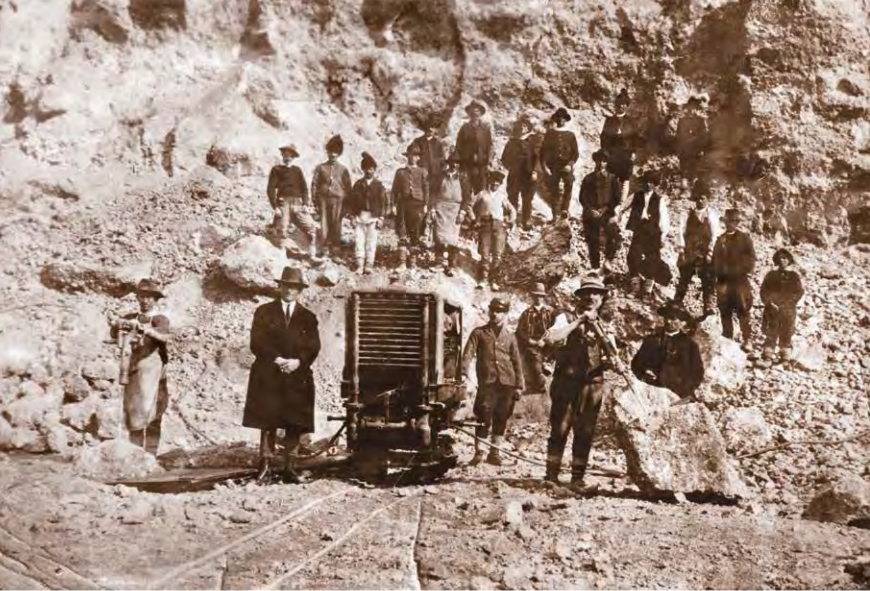
Cariera Lespezi, mecanizarea exploatării cu primele perforatoare și compresoare
