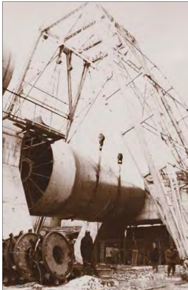
Montajul virolei de câmp la cuptorul nr. 7
