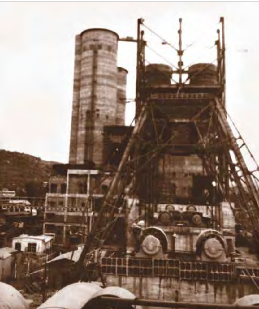
Grupurile de sprijin, montarea cuptorului nr. 7
