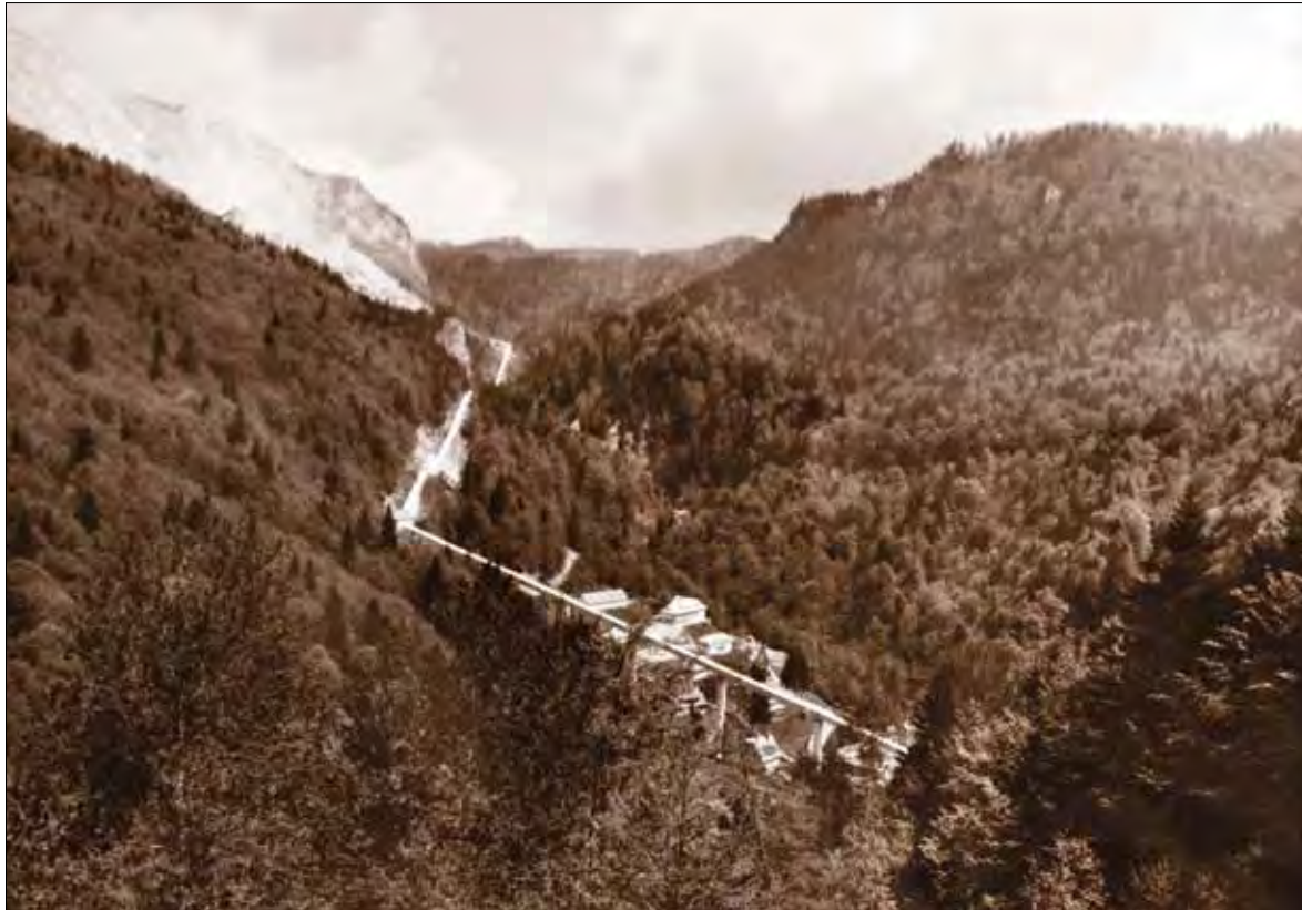
Banda transportoare de calcar tronsoanele 2 și 3; hidrocentrala Dobrești
