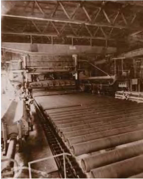
Instalația pentru fabricarea tuburilor de azbociment – formare
