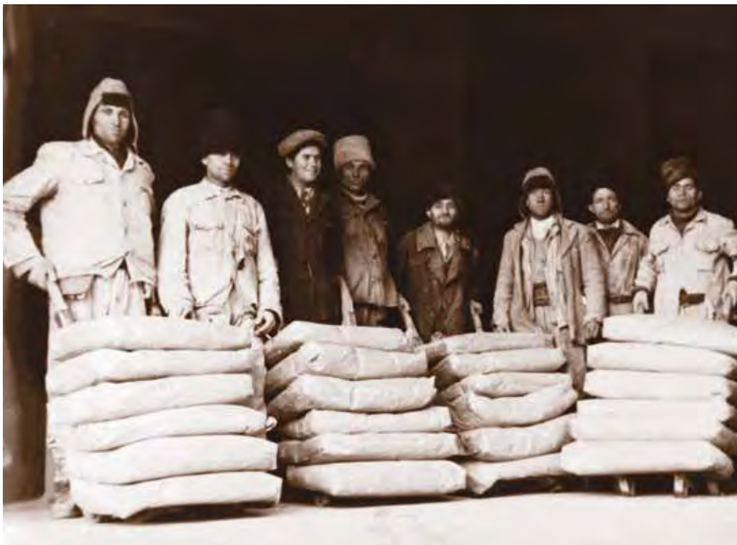
Transportul cimentului înșăcuit cu cărucioare (lize)
