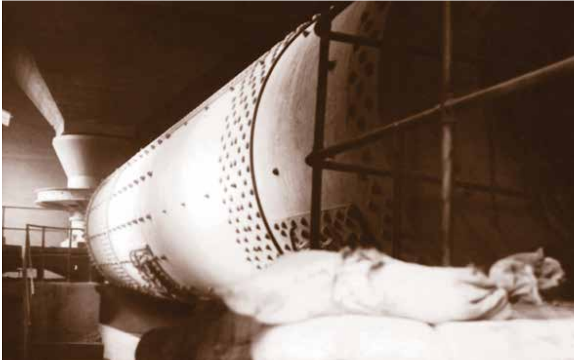
Moară de ciment ø1,8 x 11m, având o producție de 6,67 t/h
