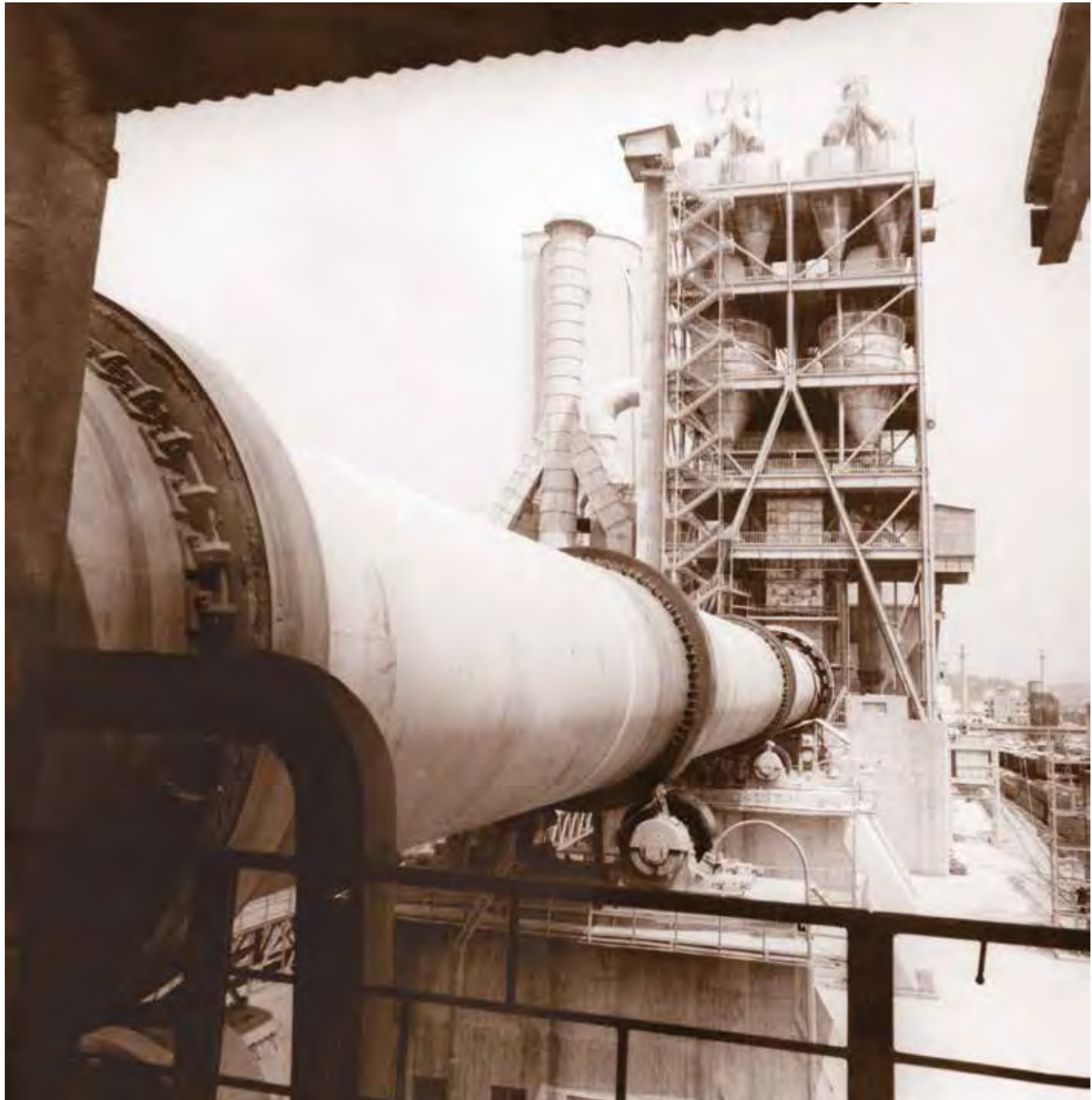
Cuptorul nr. 7 finalizat, vedere spre turnul cicloanelor.
