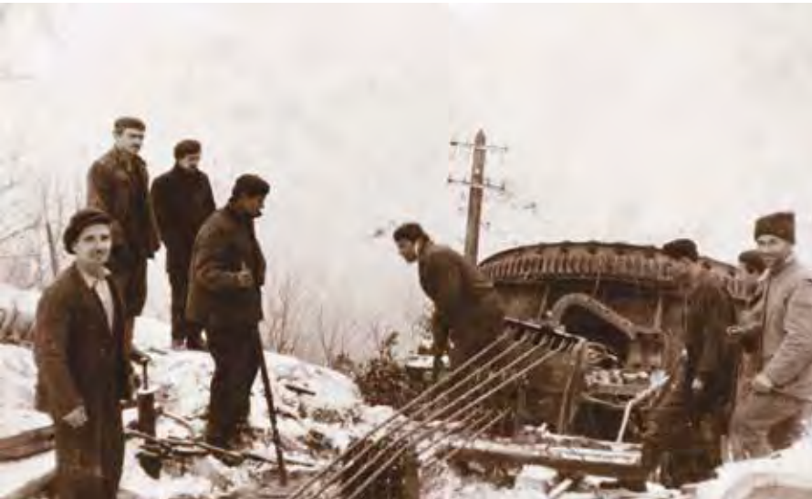
Transportul inelului de rotire al unui excavator spre cariera Lespezi
