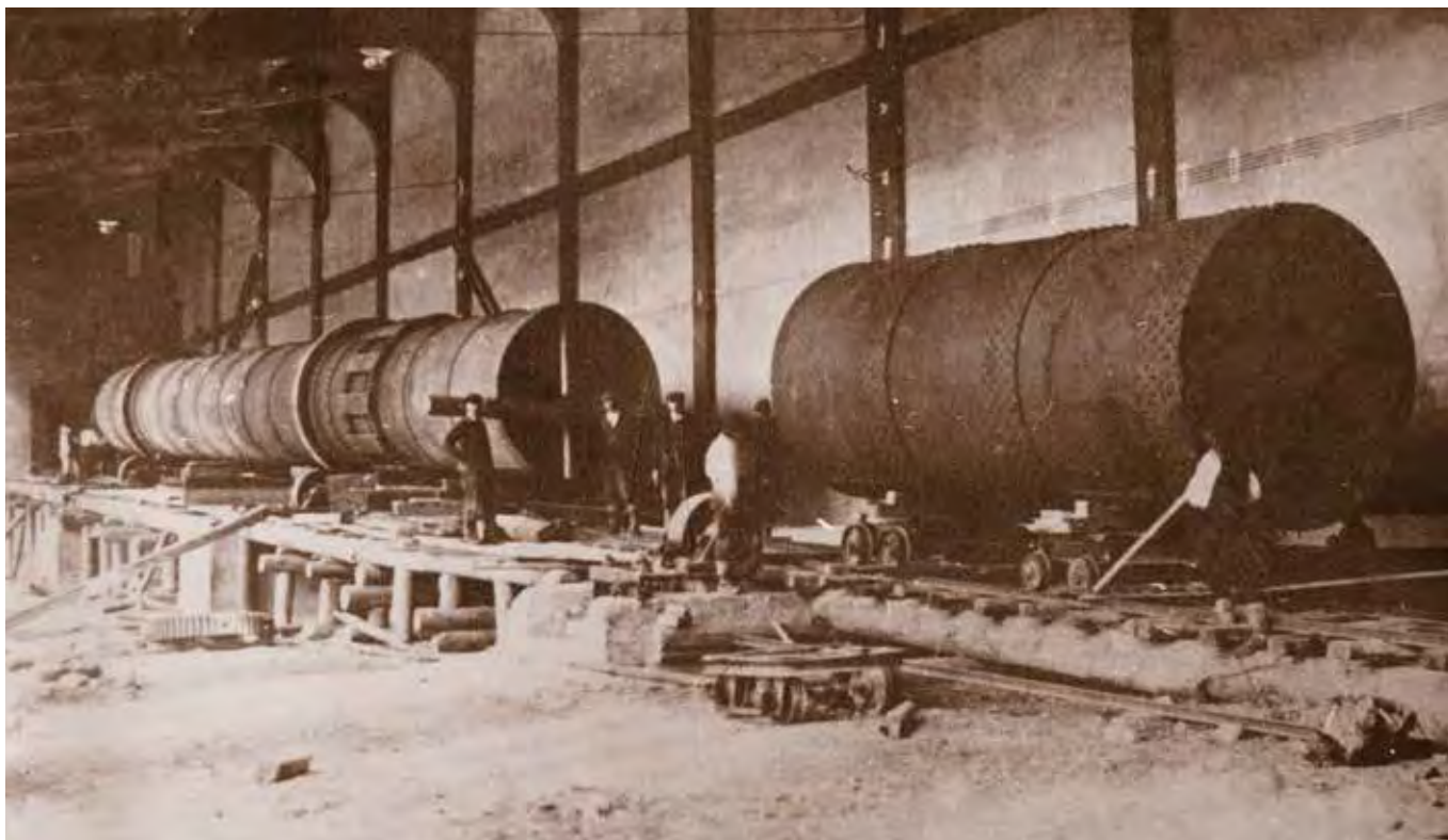
Aspecte de la montarea în hală în 1922 a primului cuptor de clinker tip Polysius de capacitate 6,35 t/h. Acest cuptor asigura clinkerul necesar realizării producției de 15 500 t. ciment în anul 1923.
