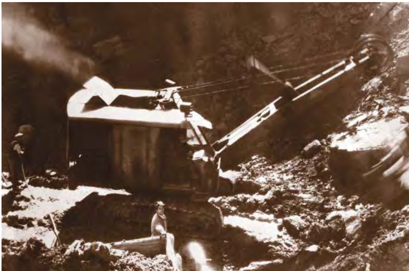
Excavator în cariera Lespezi
