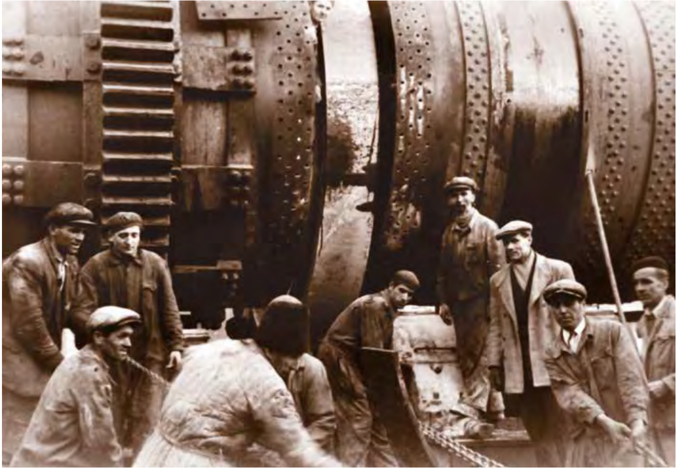
Reparație la cuptorul nr. 4
